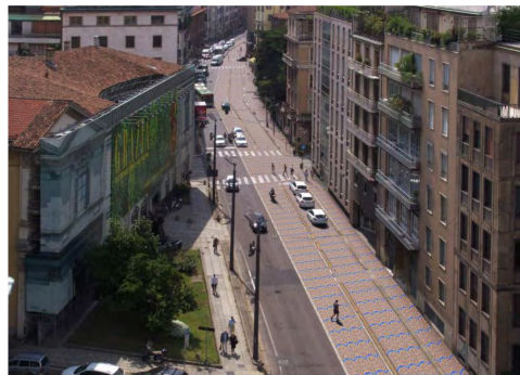
Figura 2.24: Un primo esempio di pavimentazione, a cubetti di porfido, per far rivivere il percorso storico dei Navigli
