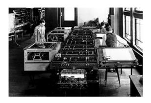
Vannevar Bush, MIT, costruisce il Differential Analyzer, con capacità di integrazione e differenziazione. (1930)
